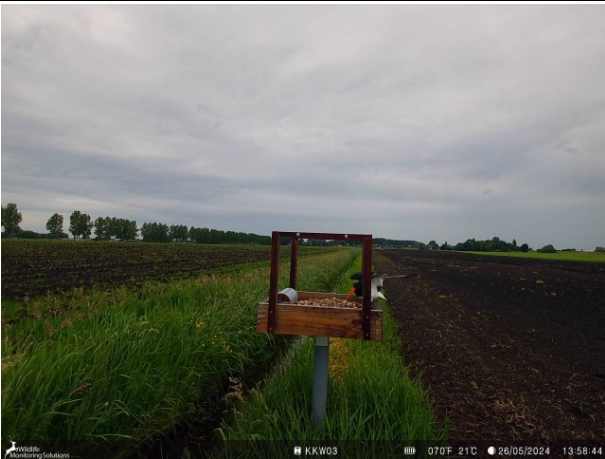
Op 26 mei is de draagconstructie voor het dak geplaatst
